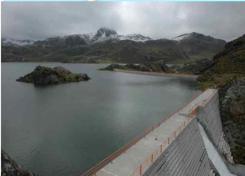
Represa de Antacoto, componente de Marca III, llenó su capacidad total de 120 millones de m 3 . Es la segunda vez que rebosa, desde su inauguración en 1999.
