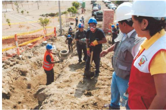
Ministra de Vivienda supervisa trabajos en Carabayllo, y en Santa Rosa
