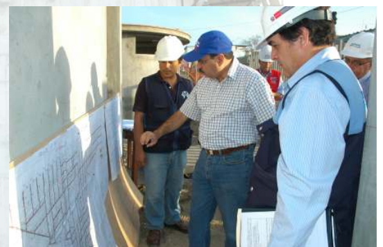
Viceministro de Construcción y Saneamiento inspecciona avance de obras del Esquema San Juan Macías y Anexos (San Martín de Porres y Callao), y en Villa El Salvador, Esquemas Parque Metropolitano y Codimuves.
