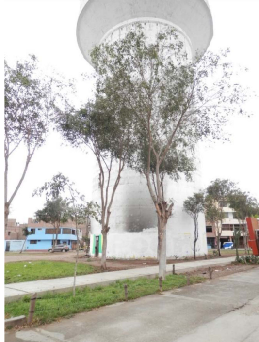
Imagen N° 4: Vista de reservorio ubicado en zona de áreas verdes.
